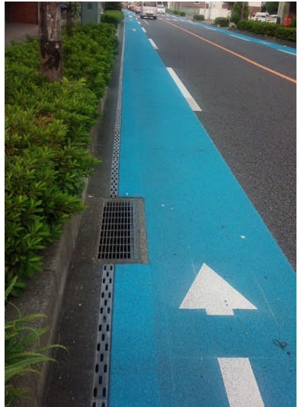
【写真2】自転車レーン（蕨市）
