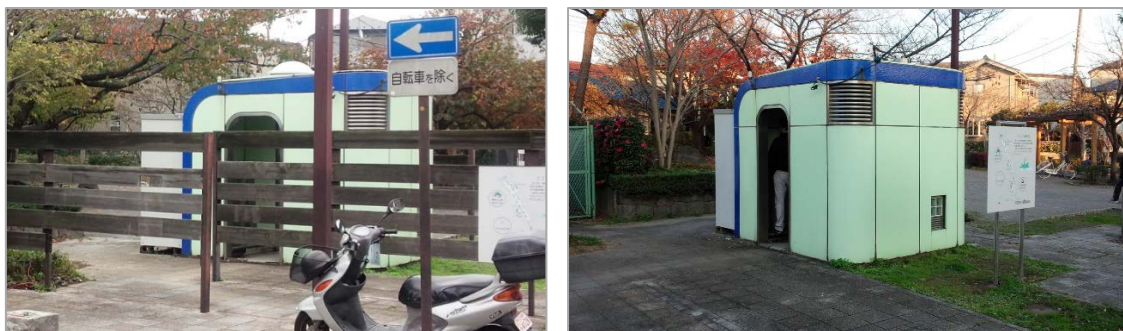
▲喜沢第一公園：トイレで物騒な事案が発生していたことから、死角を少なくするために目隠し柵が撤去された。
